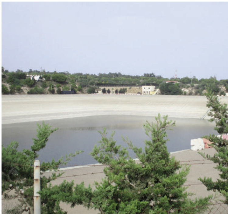
Embalse de las Adelfas, en Melilla, y a la derecha planta desalinizadora de Melilla, en los Cortados de Aguadú, lugar situado próximo a la punta de Rostrogordo.
